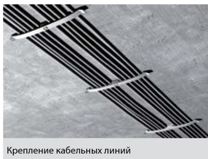
Крепление кабельных линий
