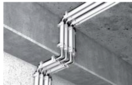
Крепление пластмассовых изоляционных труб
